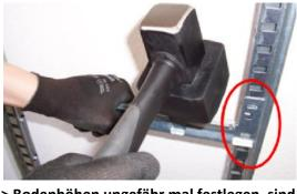
> Bodenhöhen ungefähr mal festlegen, sind jederzeit schnell abgeändert. Überall die Bodenträger Doppelhaken gerade an die Ständer anlegen und mit Fäustel 1000g mit Gummiaufsatz, in die Löcher einschlagen.
